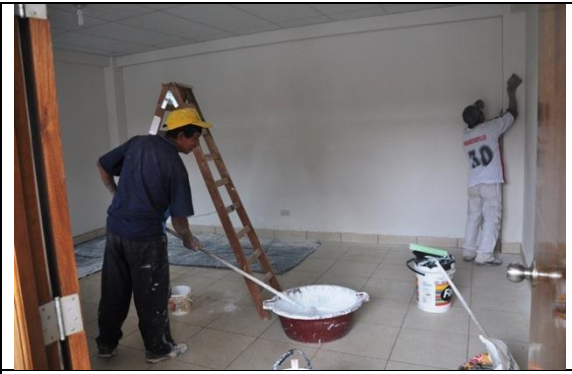
Pintando las aulas modalidad contrato
